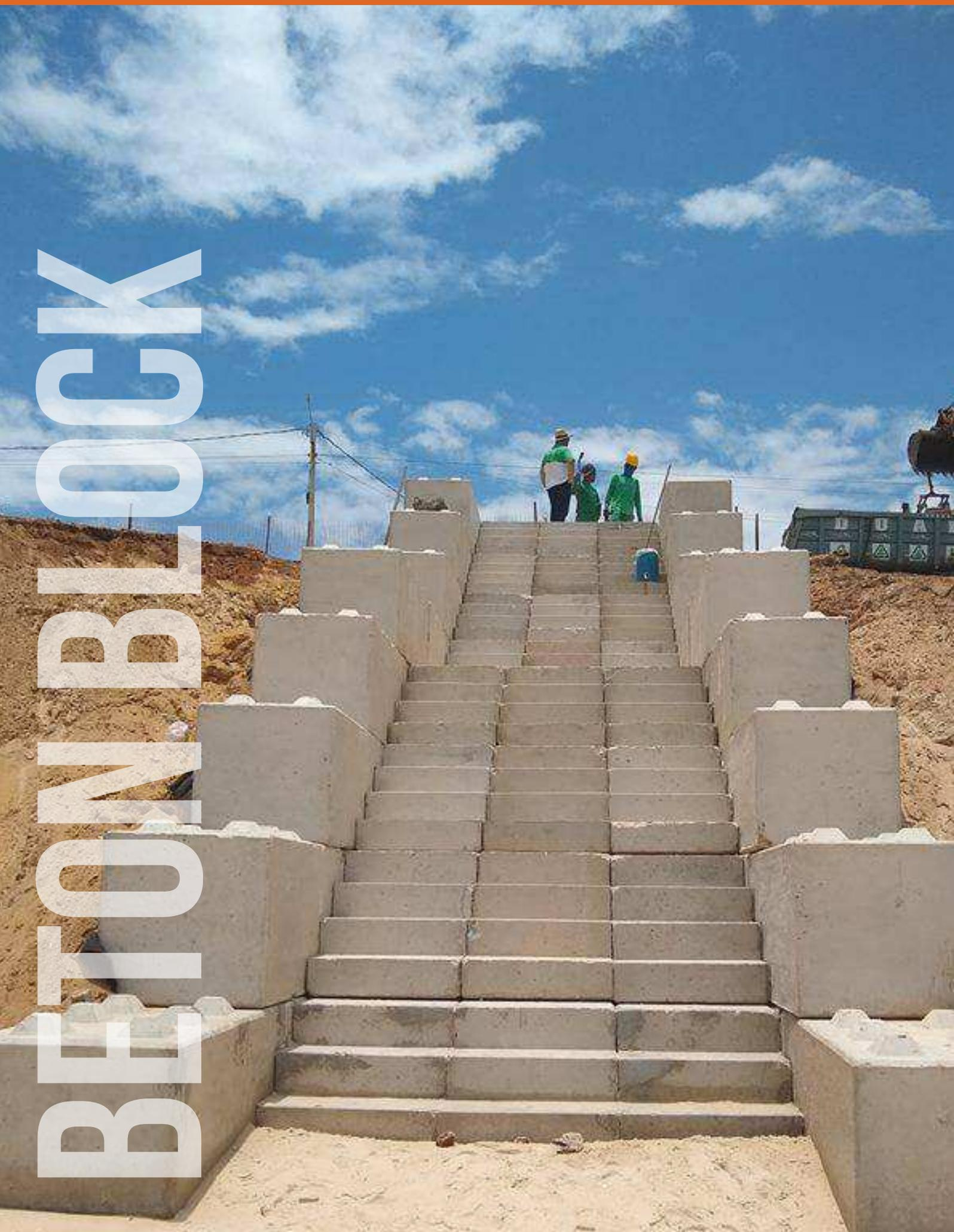
I mattoni modulari Beton Block sono dei blocchi di calcestruzzo che possono essere utilizzati in modo multifunzionale: per muri di sostegno, pareti divisorie, protezione contro le inondazioni o soluzioni innovative per l'edilizia.
